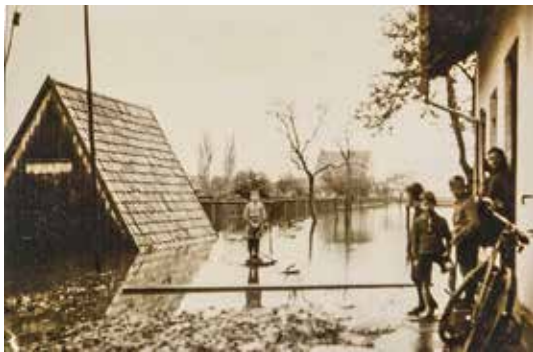
Für Luftschutzübungen steht in den 1930er-Jahren in Leitershofen ein einfacher Dachstuhl zu Verfügung.
