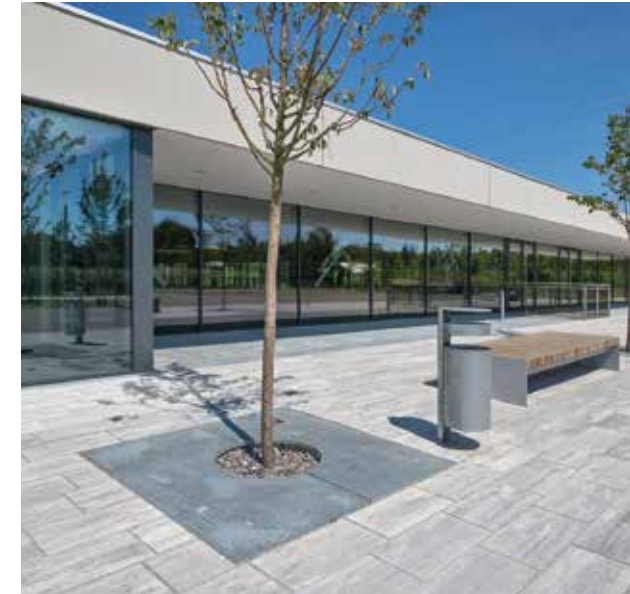
Blick auf die neue Sporthalle Stadtbergen.
